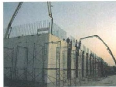
شکل ۳-۲۷- عدم نیاز به قالب‌بندی برای اجرای بتن
