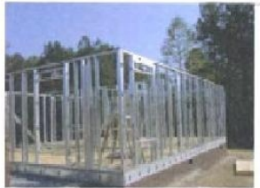
۱-۲- اعضای سازهای سیستم قاب فولادی سبک نورد سرد
