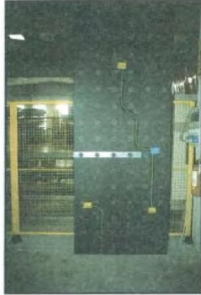
شکل ۳-۲۶- عبور خطوط و لوله‌های تأسیساتی از دیوارها
