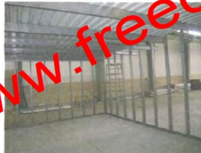
شکل (۱-۹) - یکپارچگی اسکلت ساختمان‌های قاب فولادی سبک نورد سرد
