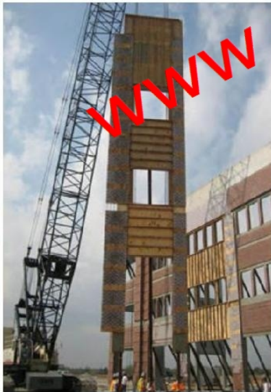
برپاسازی يك قطعه چند طبقه به روش تیلت آپ
