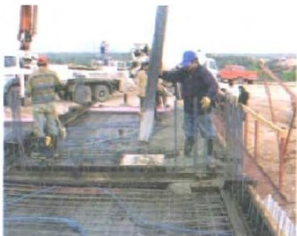
شکل ۳-۴- بتن ریزی سقف با استفاده از پمپ بتن و لوله
