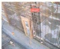
شکل ۳-۴- اجزای تسبیحات الکتریکی و مکانیکی در دیوار
