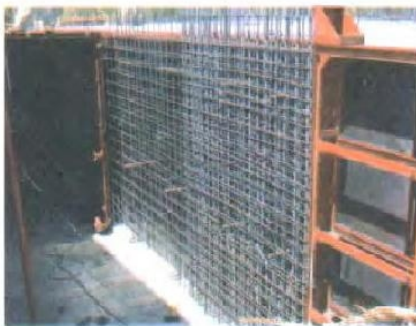
شکل ۲-۳۶- اجرای قالب‌بندی دیوار
