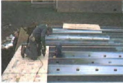
شکل (۱-۲۲) - سیستم کف کاذب
