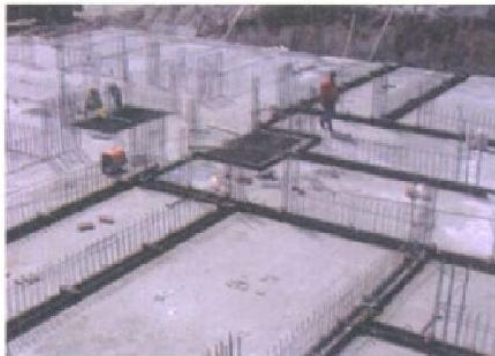
شکل ۳-۲- اجرای سقف در سیستم سازه بتنی با قالب پیوسته
