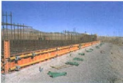
شکل ۲-۳۴- قالب بندی پی پس از اجرای بتن مگر
