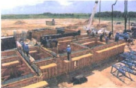
شکل ۲-۲۵- قالب بندی دیوار بلافاصله پس از گرفتن اولیه پی (یا سقف)
