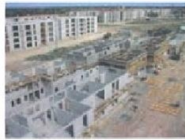
شکل ۲-۲۳- اجرای عایق کاری بتن
