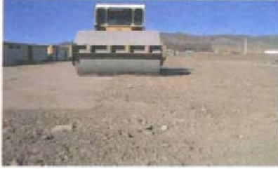
شکل ۲-۳۳- تراکم کردن بستر
