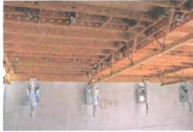
شکل ۲-۳- قالب‌بندی و بتن‌ریزی سقف، اتصال قالب‌های مدولار و تیرچه‌ها با بست‌های مخصوص
