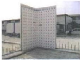
شکل ۳-۱۴- دیوارهای باربر متشکل از دو لایه
