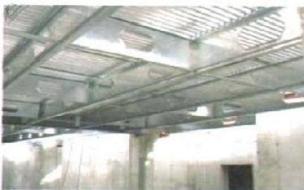
شکل (۱-۳۱) - اجرای سقف در سیستم قاب فولادی سبک نورد سرد
