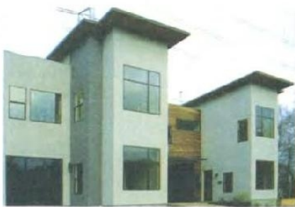
شکل ۳-۲۷- استفاده از سیستم قالب‌های عایق ماندگار (ICF) در واحدهای کوچک مسکونی
