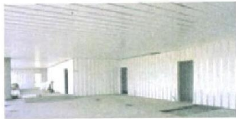
شکل ۳-۵- استفاده از صفحات گچی برای نازک کاری
