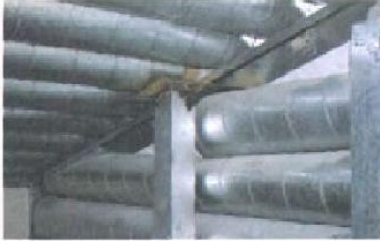
شکل ۵-۷- اتصال لوله های گالوانیزه به اعضای عمودی
