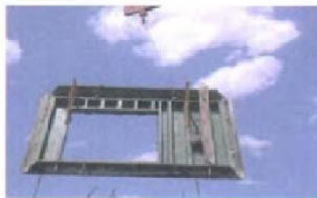
شکل ۳-۱۶- قرارگیری قطعات بزرگ دیوارهای خارجی و داخلی به وسیله جرثقیل برجی در محل خود
