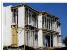
پس ریزی سقف
